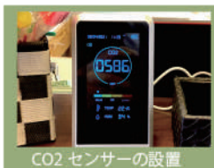
CO2 センサーの設置
